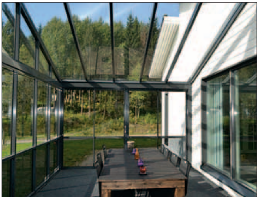
Kiinteän 1-lasisen seinän asennus L-listalla
